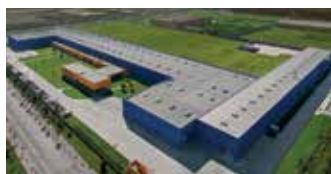
Hörmann Tianjin, Cina
